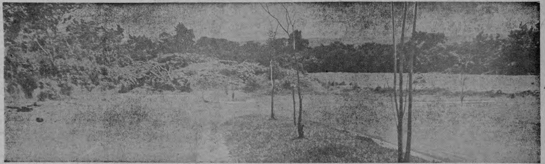
Este es el tope de la Autopista Wilson. Hasta aquí llega ahora. Se trata de realizar el resto de la obra en las mismas condiciones y características técnicas que ofrece la foto que se ve aquí, hasta llegar al Aeropuerto de El Coco. Una magnífica autopistas que se realizará con fondos empréstados.
